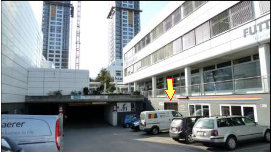
Einfahrt Tiefgarage / Migros Hobbycenter
